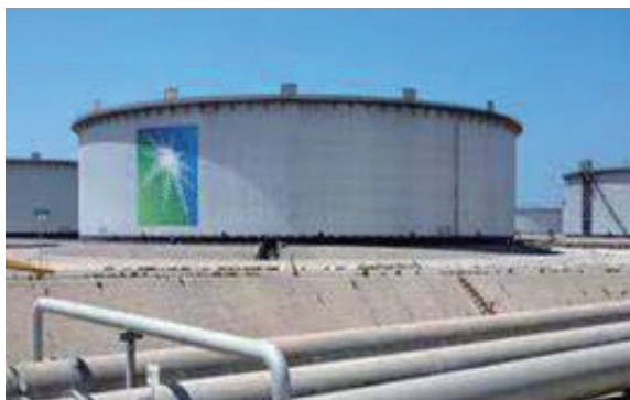
CMU 投资的沙特阿美天然气管道项目
